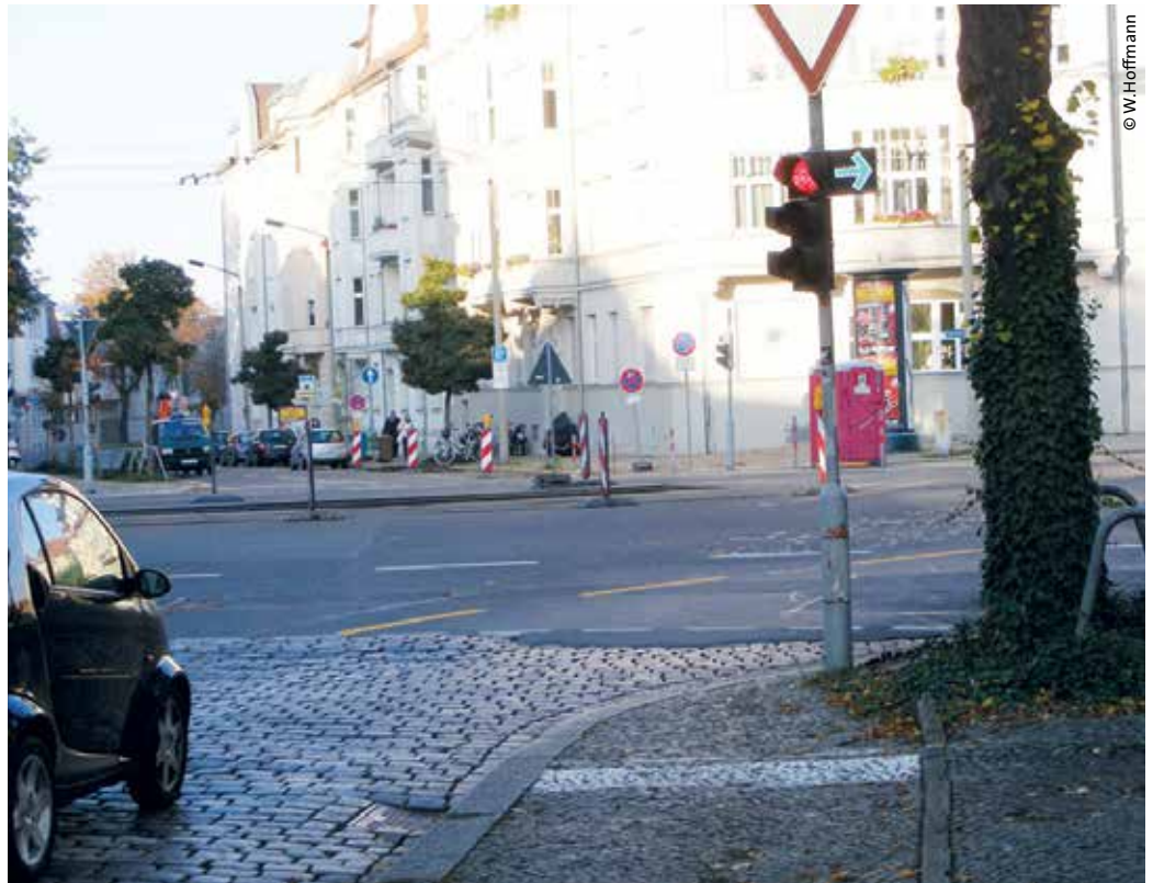
> Fehlende Querabspernung bei ausgekoffertem Gleisbett
