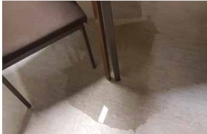
► Im Gebäude sind Decken undicht, sodass es immer wieder durchregnet.
