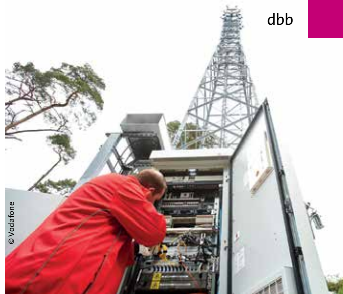
► Bundeswehr Fliegerhorst Schortens, bei Jever. Vodafone nimmt einen neuen LTE-Funkmast in Betrieb und versorgt so die Umgebung mit Breitband-Mobilfunk.
